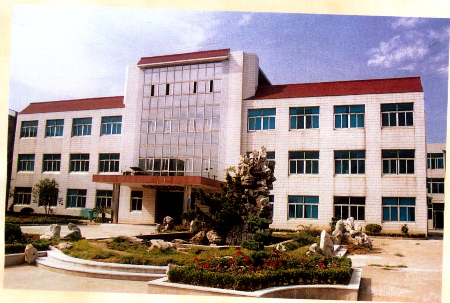
镇政府机关办公楼
