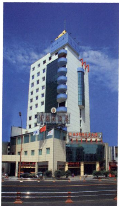
公司生产经营中枢宏源大厦
