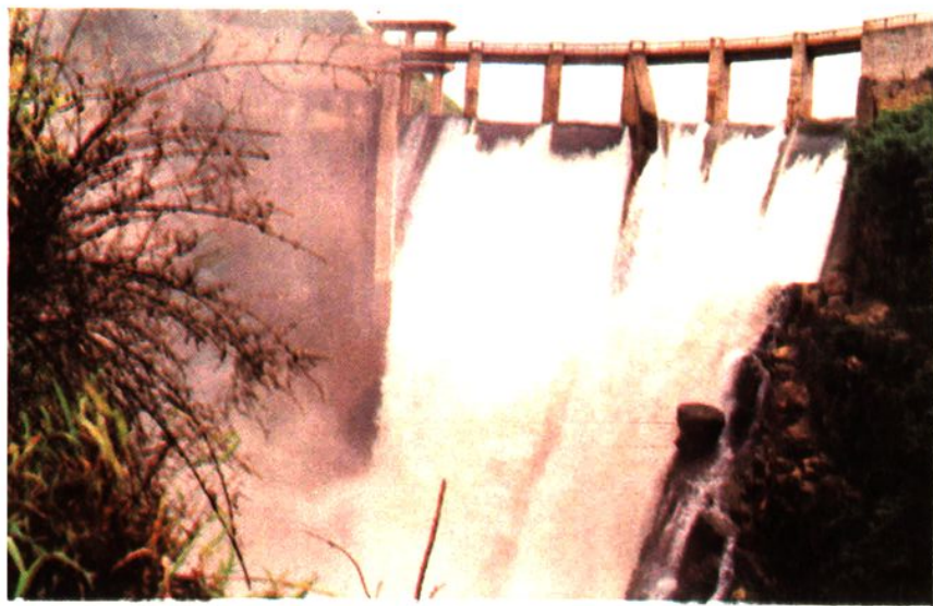
安龙县筏子河电站大坝
