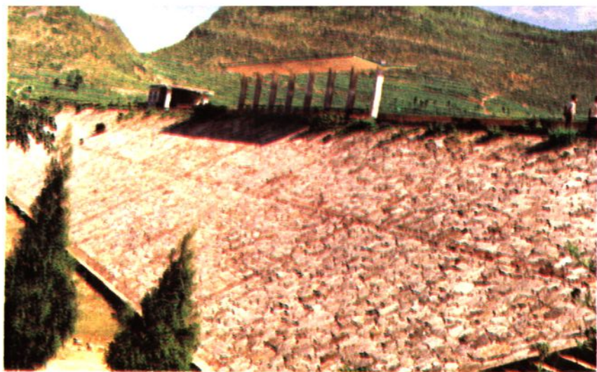
晒纳水库大坝
