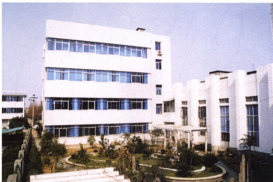
衢州中院档案楼
