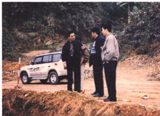
2003年11月，苏志宏局长(左一)在公路工地检查工作。
