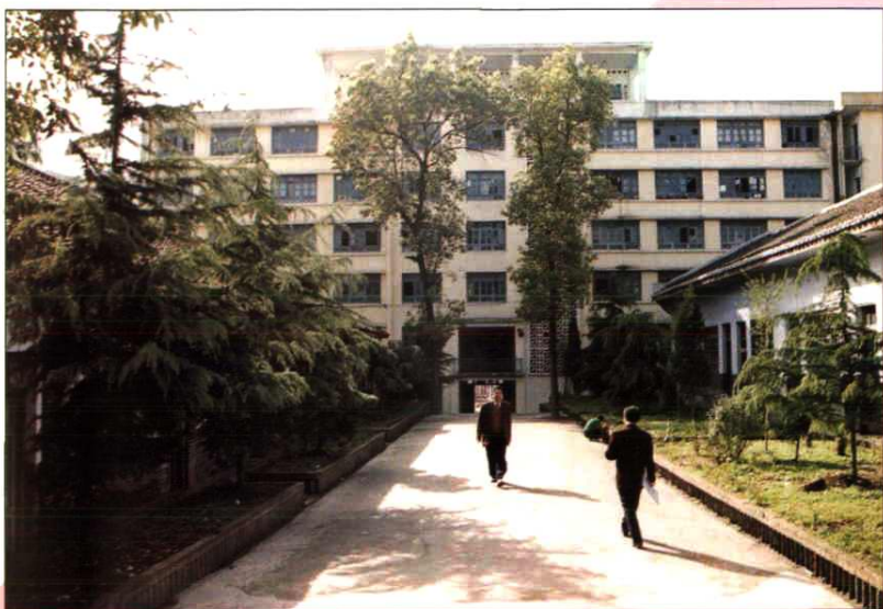
◀ 通江县人民政府办公楼
