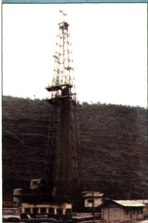
◀ 新场乡姚家坝82号油气井
