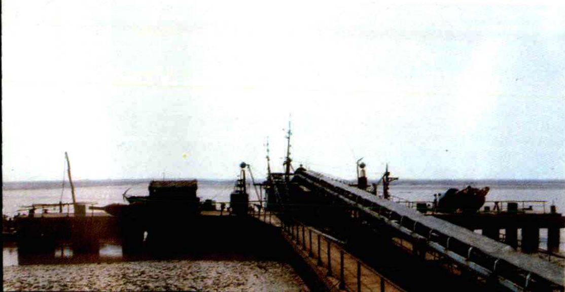
大清河口港专用装盐码头
