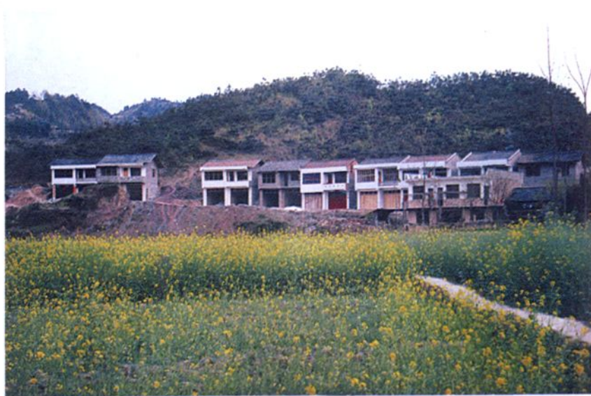
● 青島市建委扶貧白沙小岩村民建房
