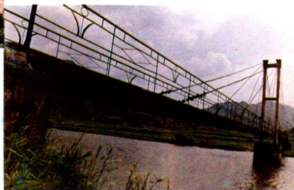
▽源滢钢索斜拉桥
