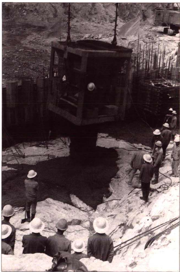
1982年6月28日，大坝第一罐混凝土开盘浇筑
