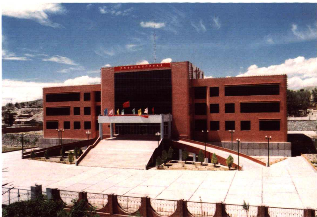
工、行委办公楼
