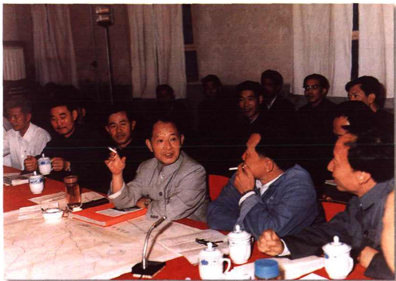
1983年7月23日，中共中央总书记胡耀邦等到达龙羊峡工地视察
