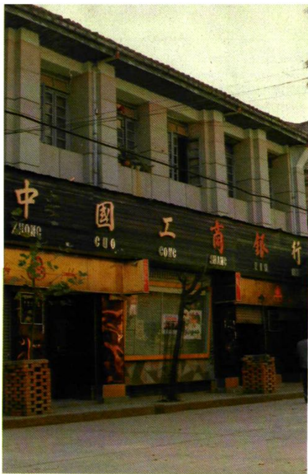
现工商银行分理处和第一储蓄所 县人民银行一九五四—一九八三年办公用房
