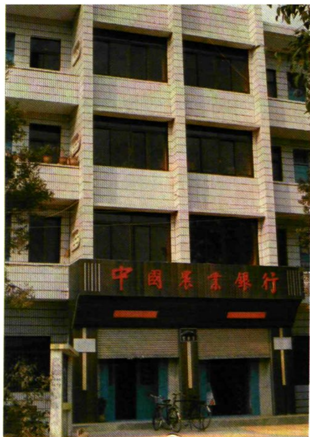
广南县农业银行支行办公楼
