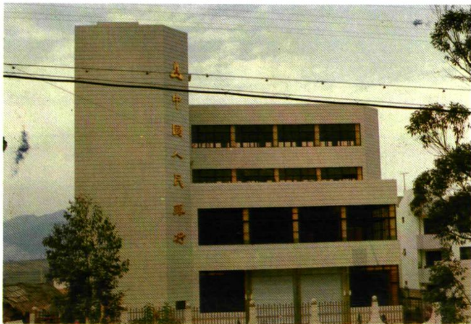
现县人民银行办公楼
