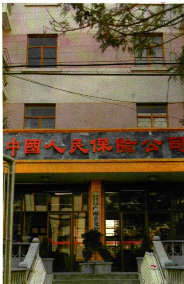
县保险公司办公宿舍楼
