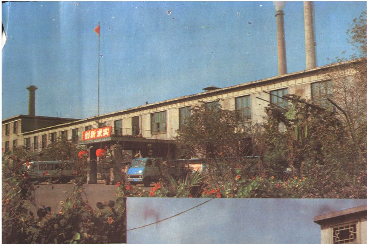
▲ 沈阳冶炼厂办公楼
