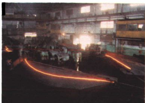
沈阳线材厂45度轧机改造工程现场一角
