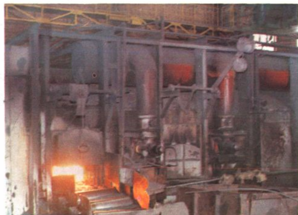
沈阳轧钢厂特等炉
