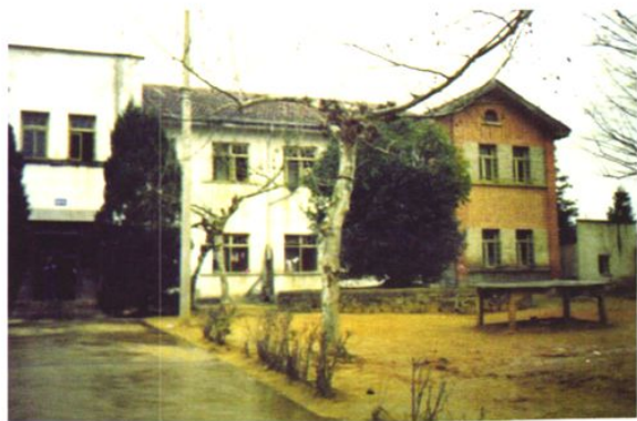
1960年竣工的教学楼（红楼）一角
