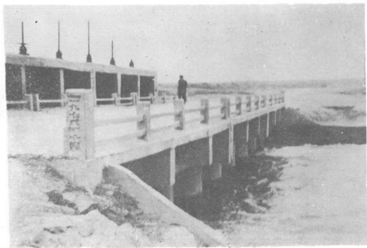
引松川头渠尾节制闸
