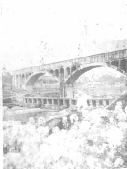
与沱灌工程配套的总、分干渠长108公里，其中渡槽18.6公里，高大壮观。图为横跨隆昌河付家桥渡槽。
