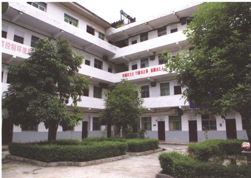
井溪乡政府办公楼
