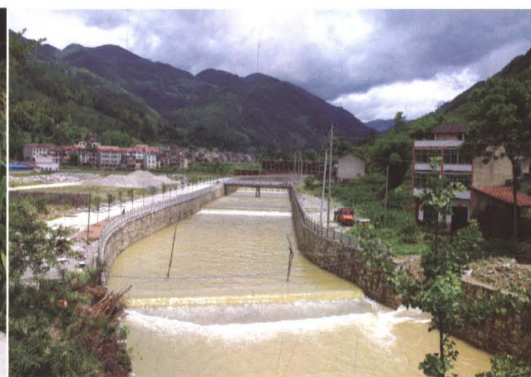
廖家河坝滚水坝
