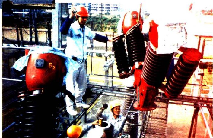
变电检修试验所 工人检修少油开关
