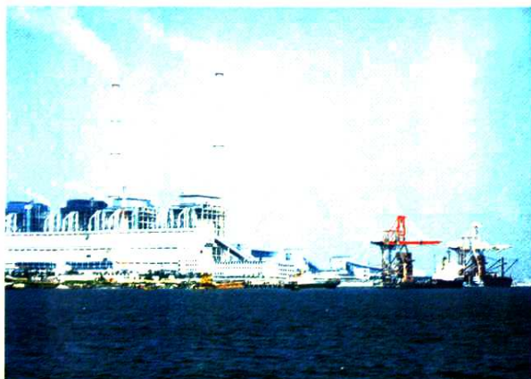
1995年建成投产的湛江发电厂（120万千瓦）
