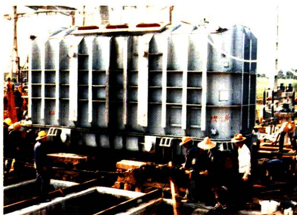
220千伏霞山变电站变压器运输现场
