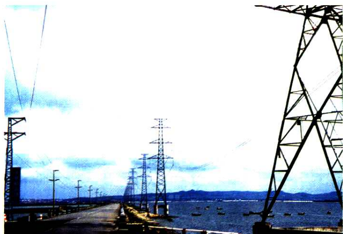
东海大坝220千伏线路铁塔
