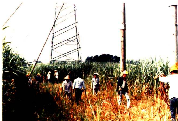
110千伏龙潮变电站出线铁塔施工现场
