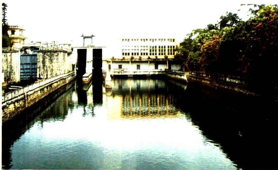
1974年建成的鹤地水库一级水电站
