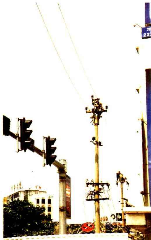
实业总公司工人安装线路
