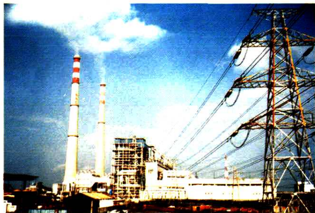
湛江发电厂220千伏输电线路出线
