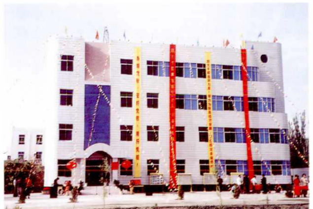
县委党校教学楼
