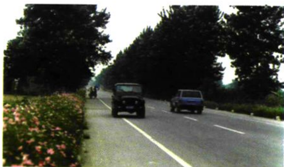
截至2003年全县17个乡镇通油路，县乡公路四通八达。
