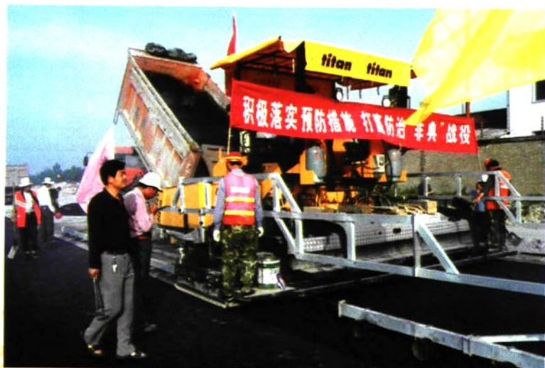
在2003年抗击“非典”斗争中，县交通局公路段工程三处职工仍坚持在施工工地。
