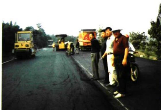
209国道线在县城过境路段的施工现场。
