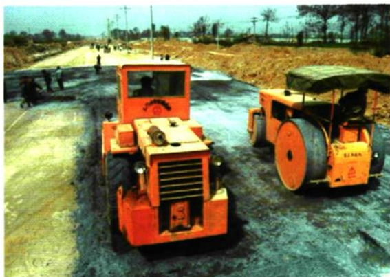
县交通局承担的陕州路西延建设工程的 施工现场。
