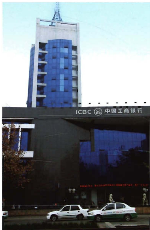
中国工商银行遵义分行新装修的办公大楼 (2007年12月拍摄)
