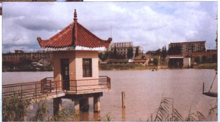
通吕运河南通闸 水文站自记水位计台
