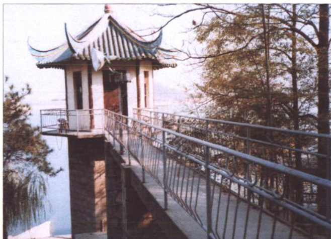
沙河水库水文站自记水位计台
