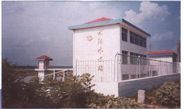
江苏最宽的沐阳水文站多跨 电动测流缆道(1280米)
