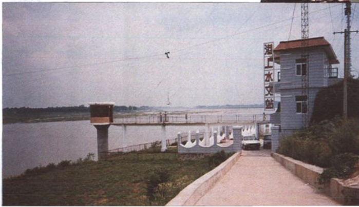
江苏首创兴建的港上水文 站多跨电动测流缆道(1010米)
