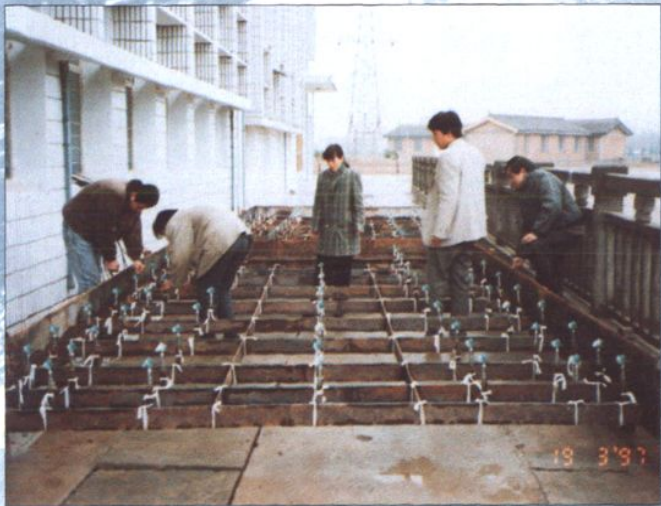
水文人员在刘老涧抽水站进行泵站效率试验
