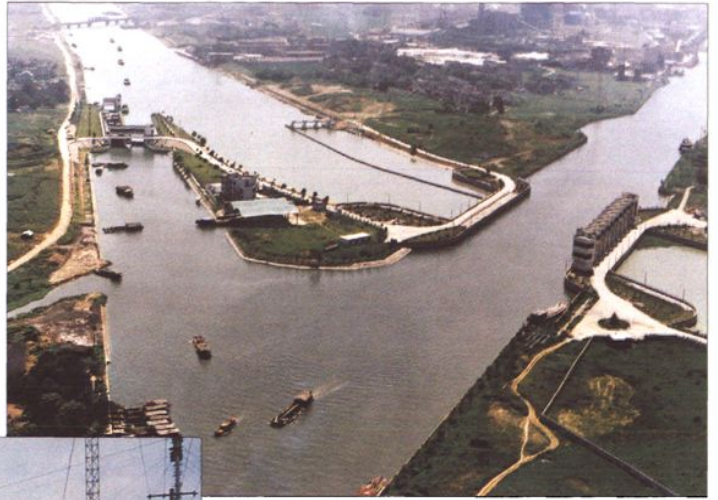
望虞河与江南运河交汇处的 望亭立交工程
