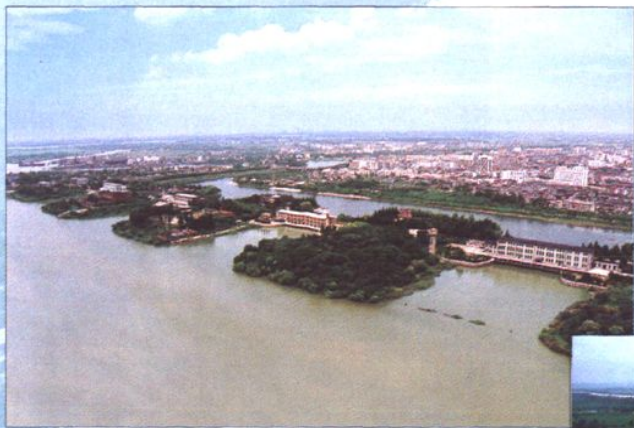
江水北调的龙头工程——江都抽水站
