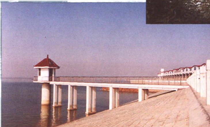
石梁河水库水文站 自记水位计台
