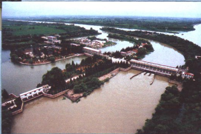
江水北调第二梯级站 ——淮安水利枢纽
