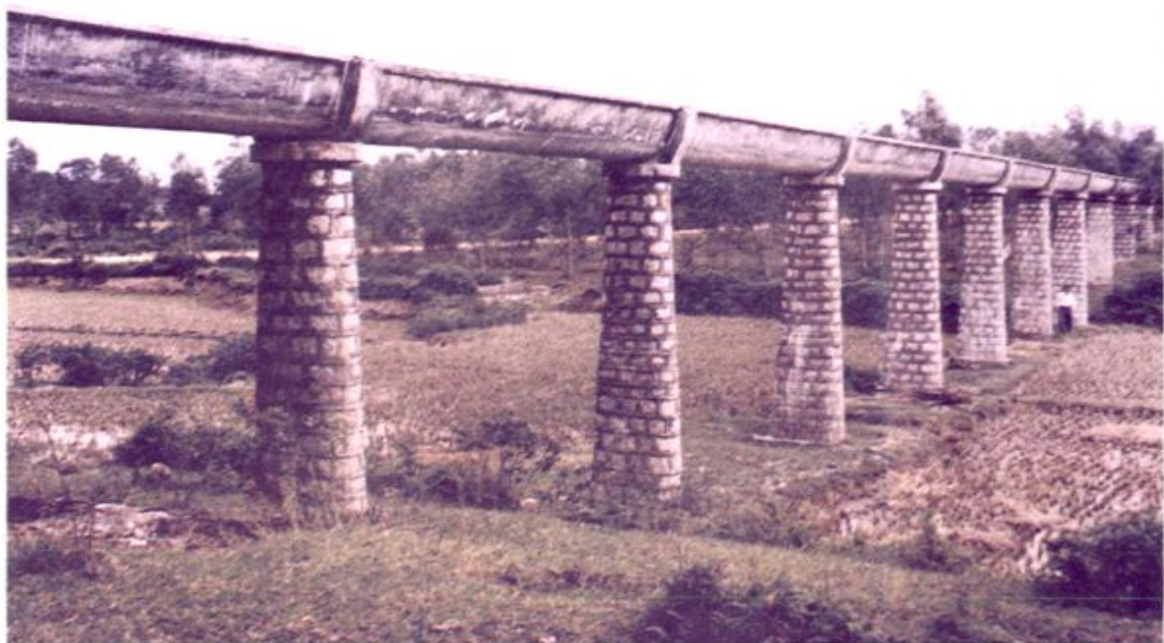
▲图为在省财税厅支持下，投资兴建的新竹镇大路东水库灌区渠道第二渡槽，全长108米。
