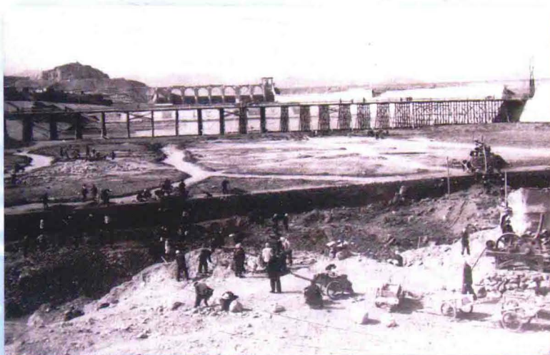
正常溢洪道建设
