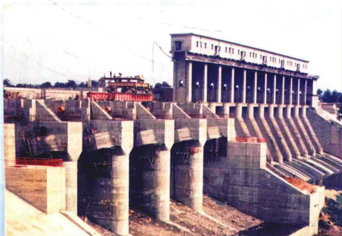
新增非常溢洪道建设
