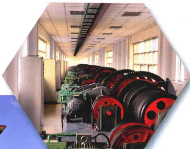
非常溢洪道机房
