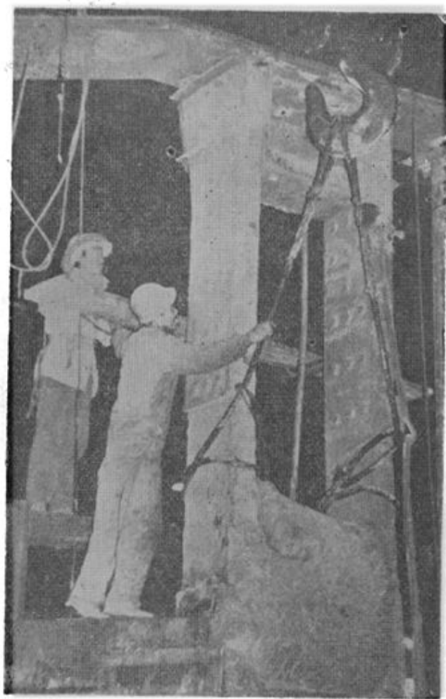
平炉大修：拆除炉体偏钢柱
