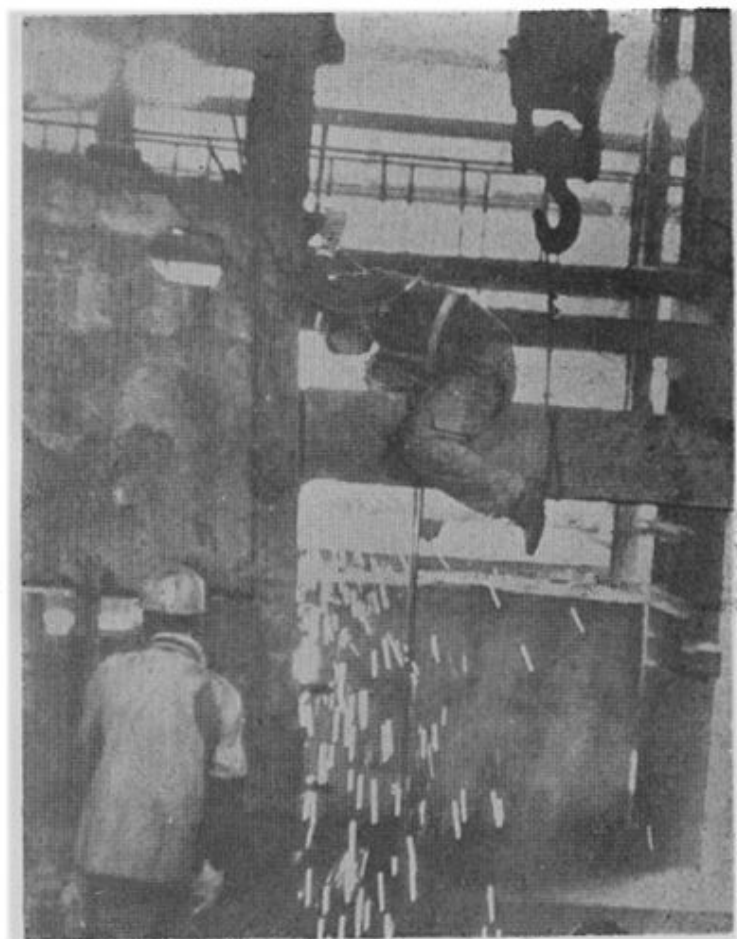
平炉大修：炉内拆除
