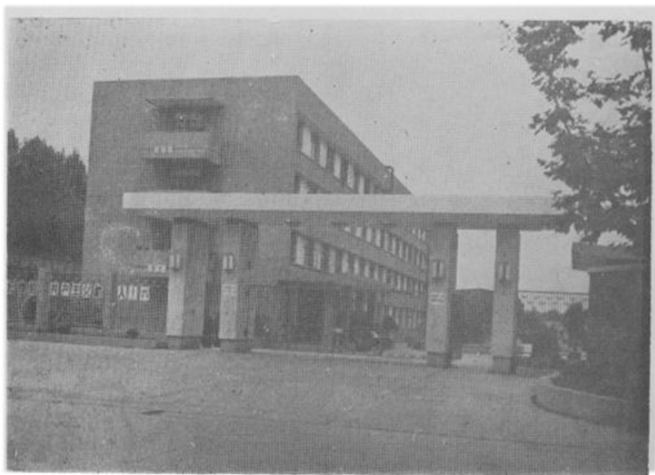
修 建 部 办 公 楼
