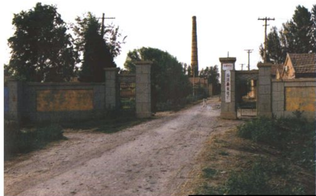
商河县发电厂外貌
