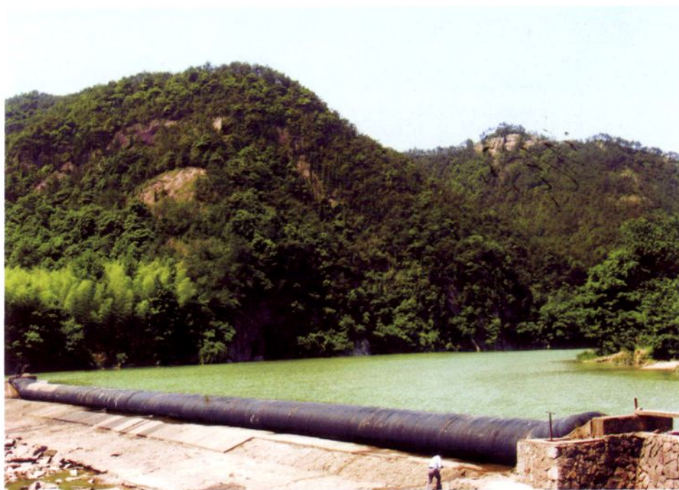
林涛水电站拦蓄水橡胶堰坝场景
