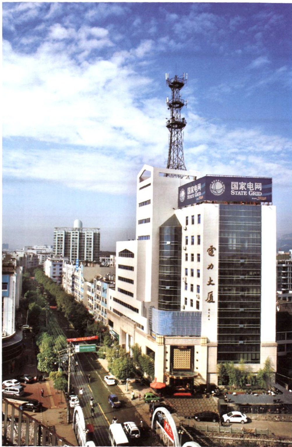
天台县电力调度大楼
