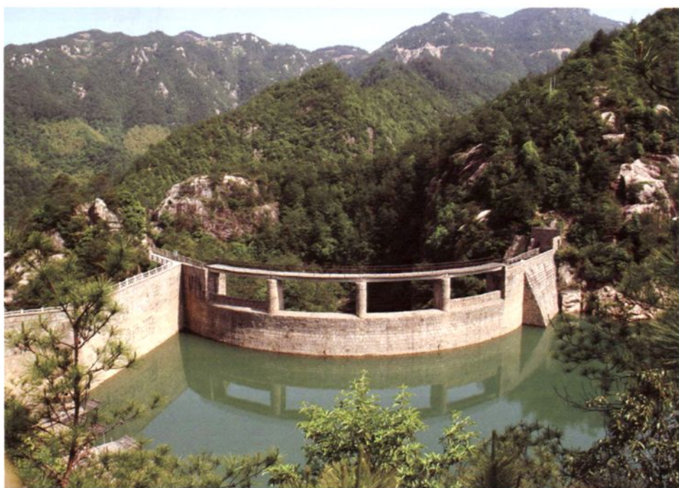
桐坑溪电站双曲拱坝
