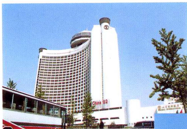
北京第一个蜂窝移动电话基站设在北京国际饭店顶层
