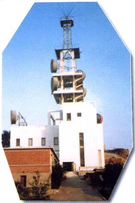
房山微波站：是北京—太原—西安 600 路微波通信干线第一个中继站。始建于 1966 年，1968 年开始担负中央电视台传输业务。
