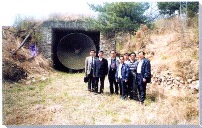
平谷微波站：是北京—承德—沈阳—长春—哈尔滨 960 路微波通信干线第一个中继站。1970 年 3 月动工，当年完成土建任务，10 月 1 日传送中央电视台节目。
