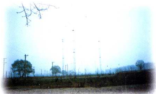
短波通信天线场区
