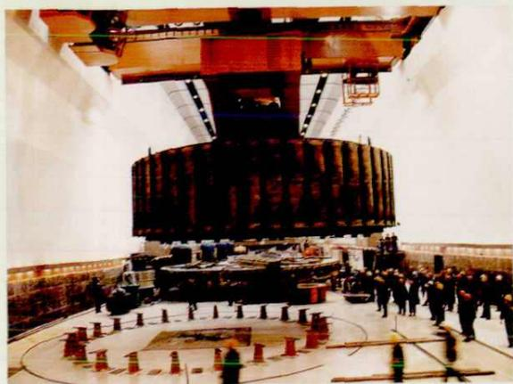
龙羊峡水电厂 32 万千瓦发电机转子吊装检修
