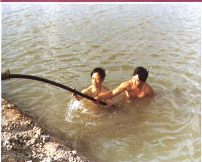
徐连线通信工程敷设水下电缆。
