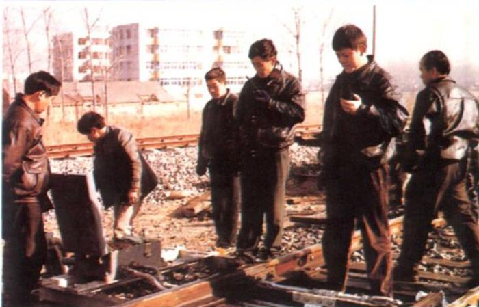
徐连线新沂站信号电动转辙机安装调试。
