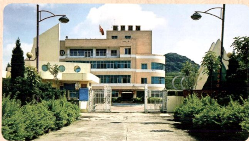
2003年建成的兴仁县双山水厂
