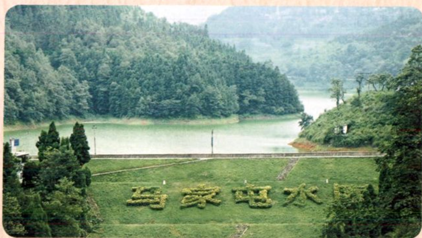
2003年除险加固后的马家屯水库
