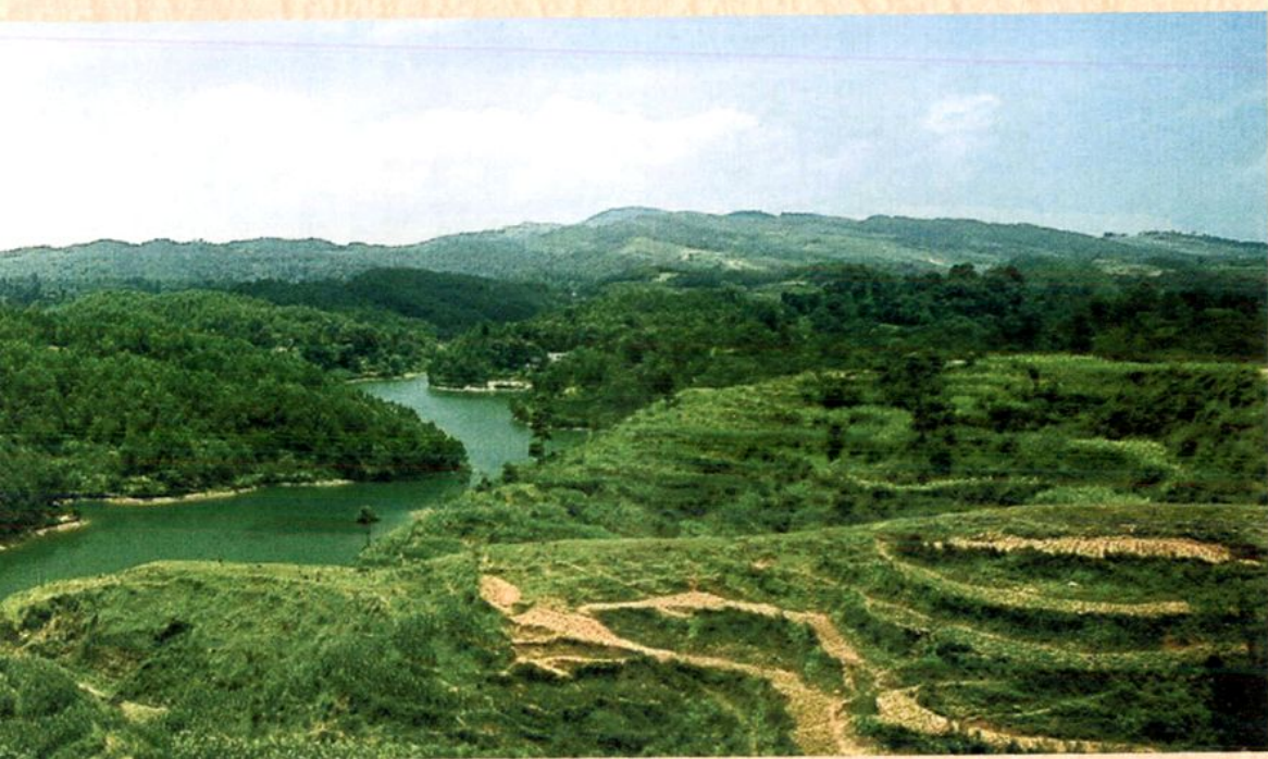
始建于1958年的三角坝水库
