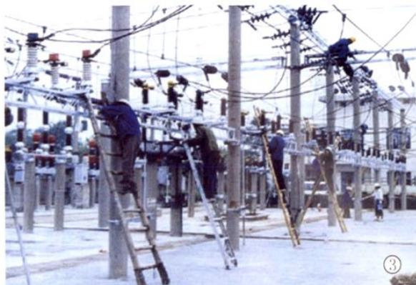
3. 1991年5月11日,变电检修工在110千伏北门变电站室外设备架构上除锈刷漆
