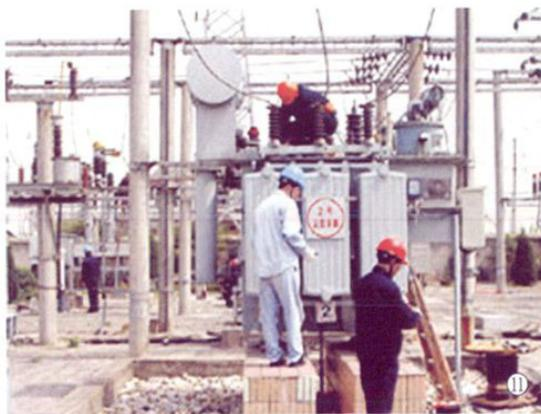
11. 2000年4月10日,电气试验工在35千伏汤泉变电站给主变压器做预防性试验
