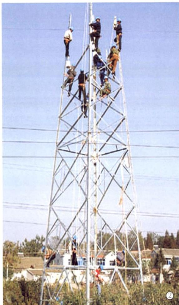
2. 1988年3月27日,线路工在35千伏江酒1、2号线路施工中架设铁塔
