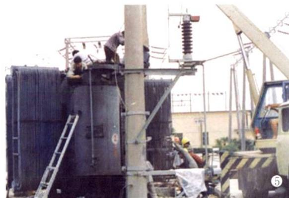
5. 1993年6月20日,变电检修工在110千伏北门变电站对2号主变压器进行吊罩检查
