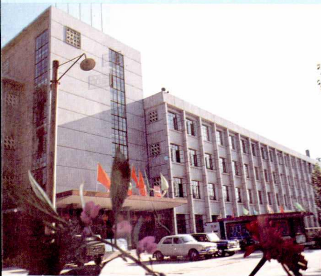
炼油实验厂办公楼
