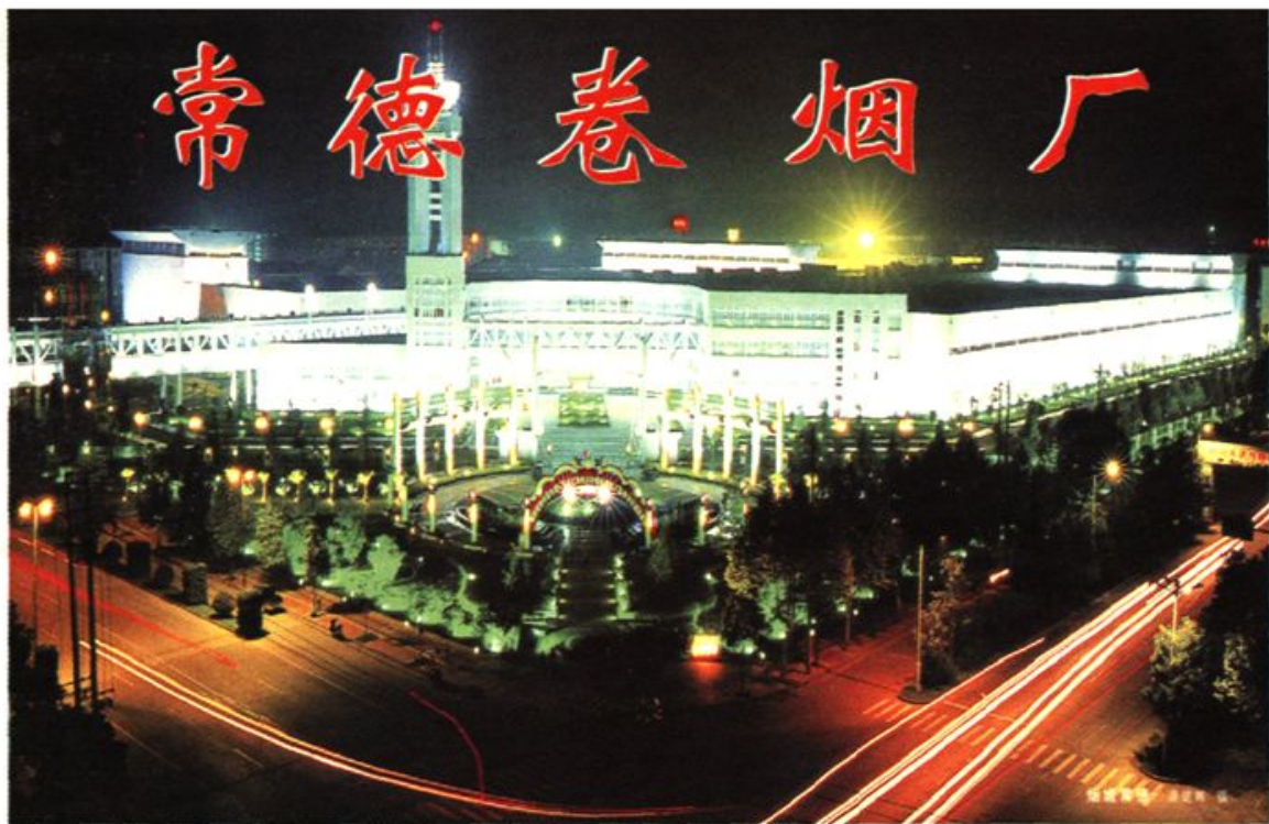
▲烟厂办公楼、技术中心外景
