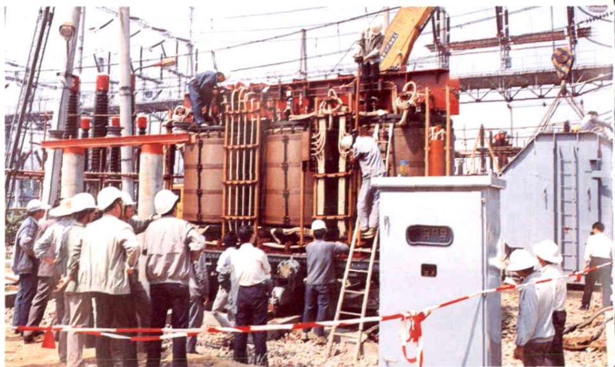
220 千伏闻堰变电所扩建
