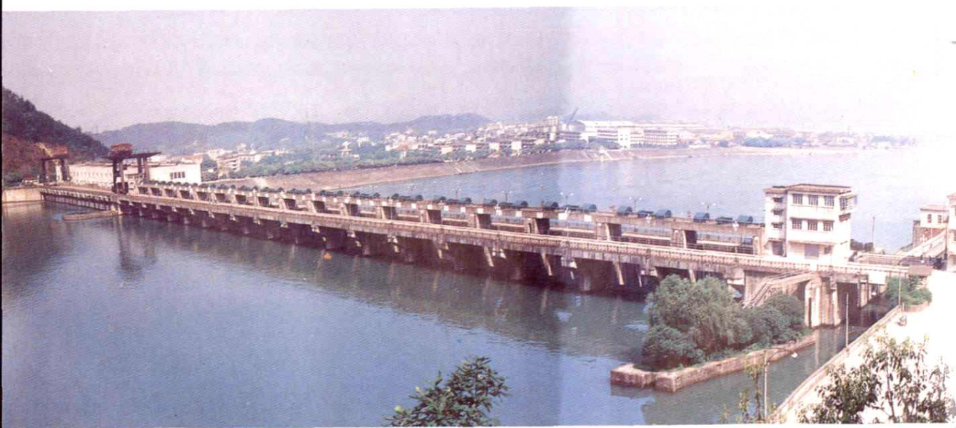
富春江水电站
