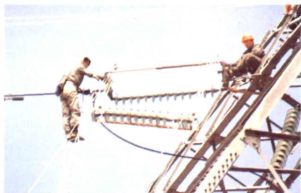
220 千伏线路带电作业
