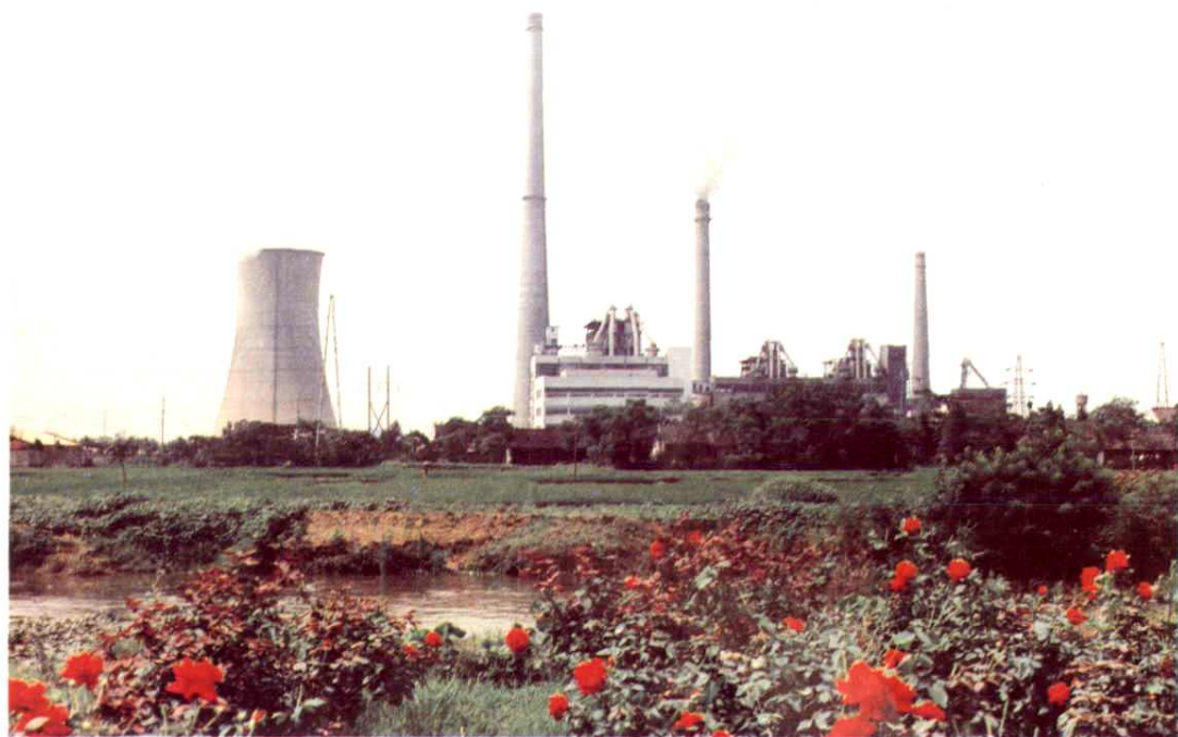
半山发电厂全景
