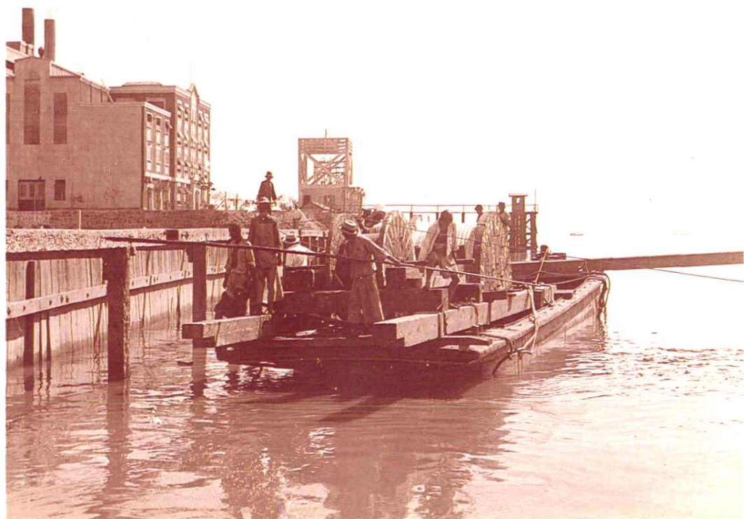
民国 22 年（1933 年）13.2 千伏钱塘江过江水底电缆施工
