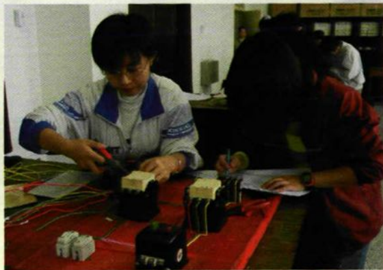
低压电器安装(实训)
