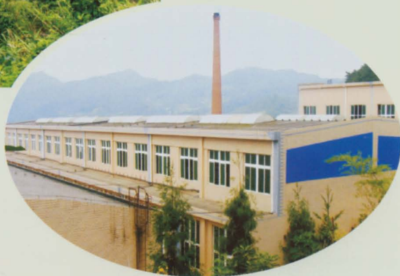
垃圾处理收费促进了垃圾处理设施建设(图为遵义市垃圾处理厂)
