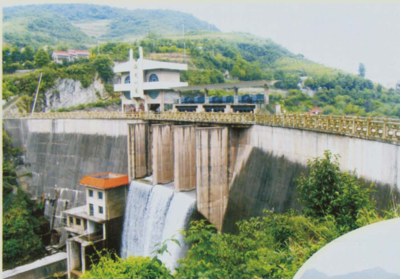
(图 为遵义海龙水库) 水价改革促进供水设施建设
