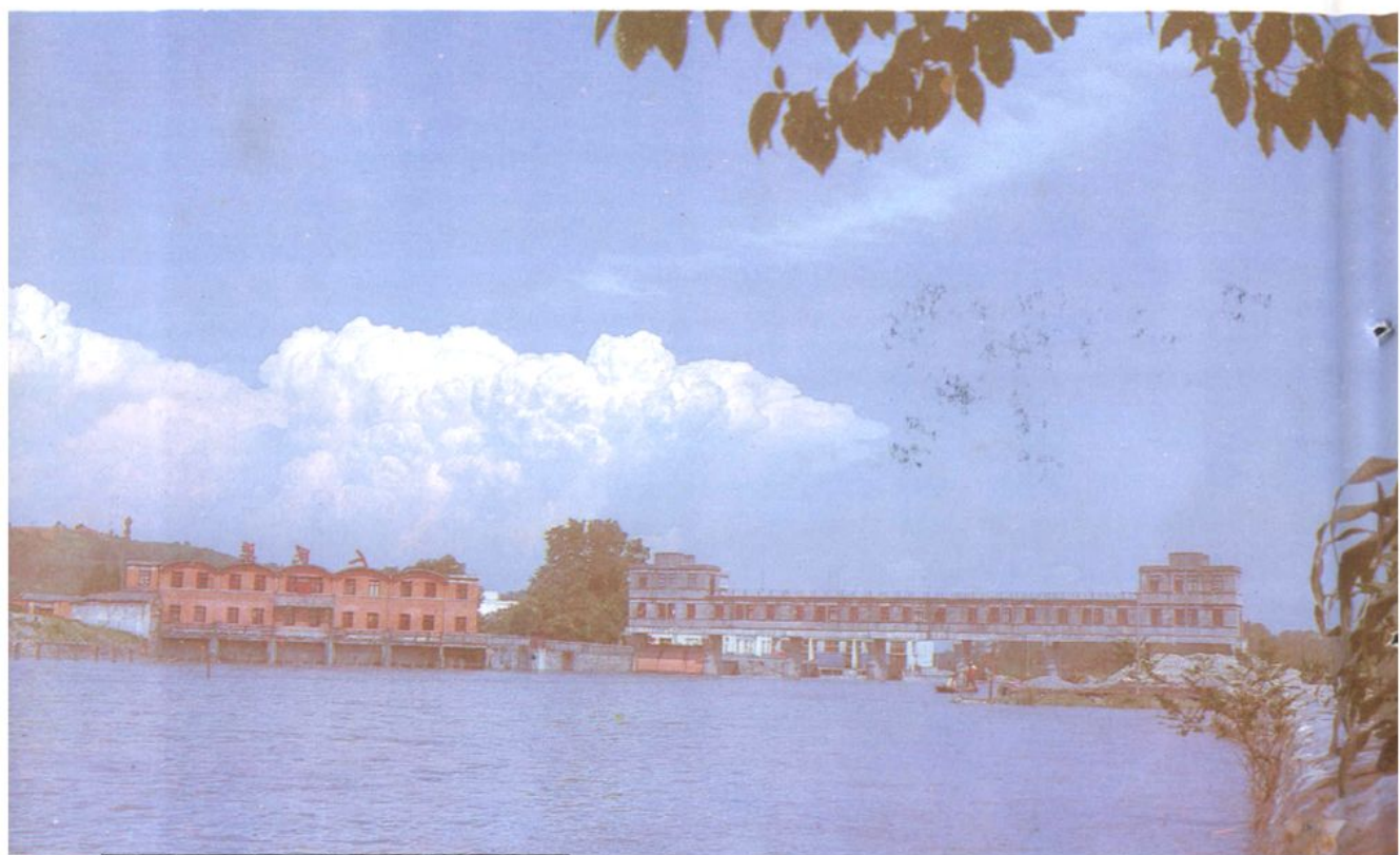
人民渠渠首枢纽全景
