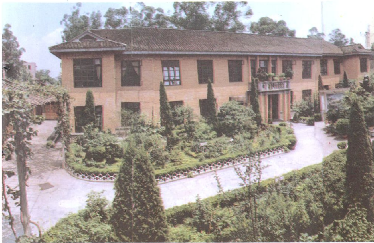
人民渠第一管理处机关
