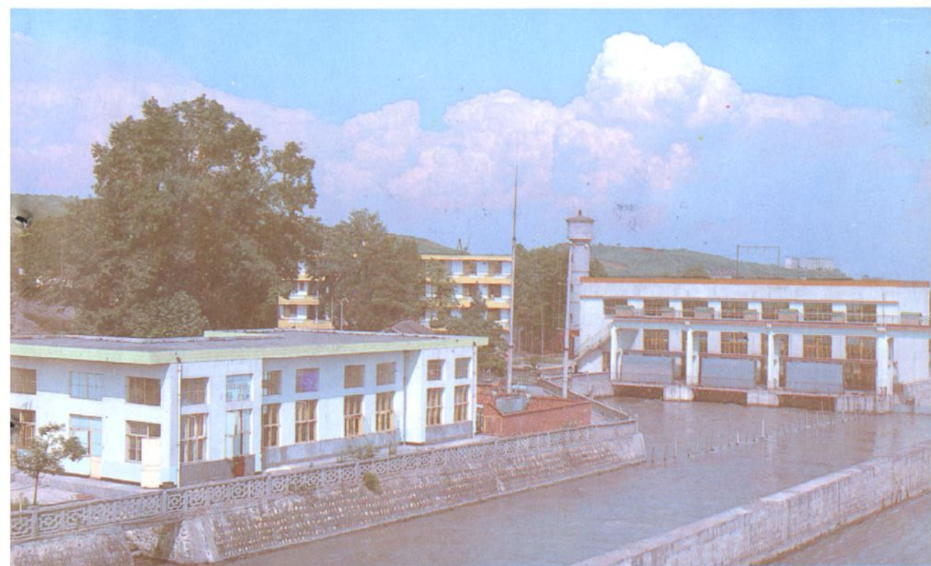
渠首电站外景
