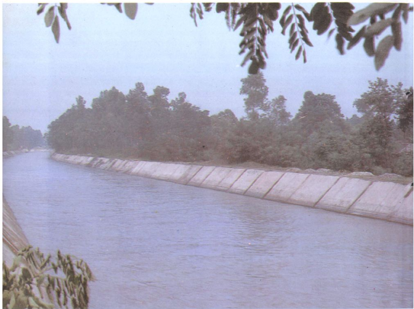
人民渠总干渠
