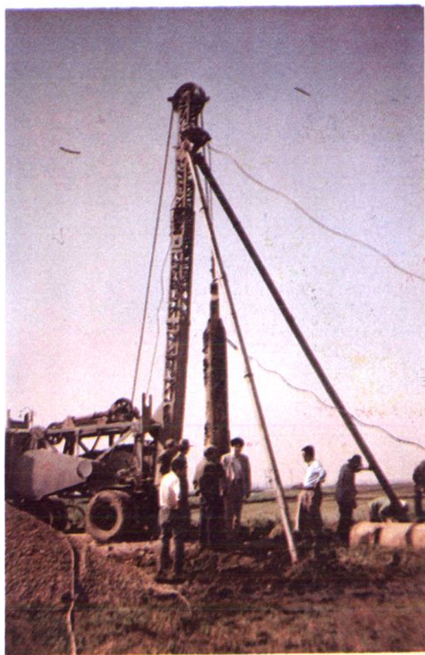
白塔镇打抗旱井现场
