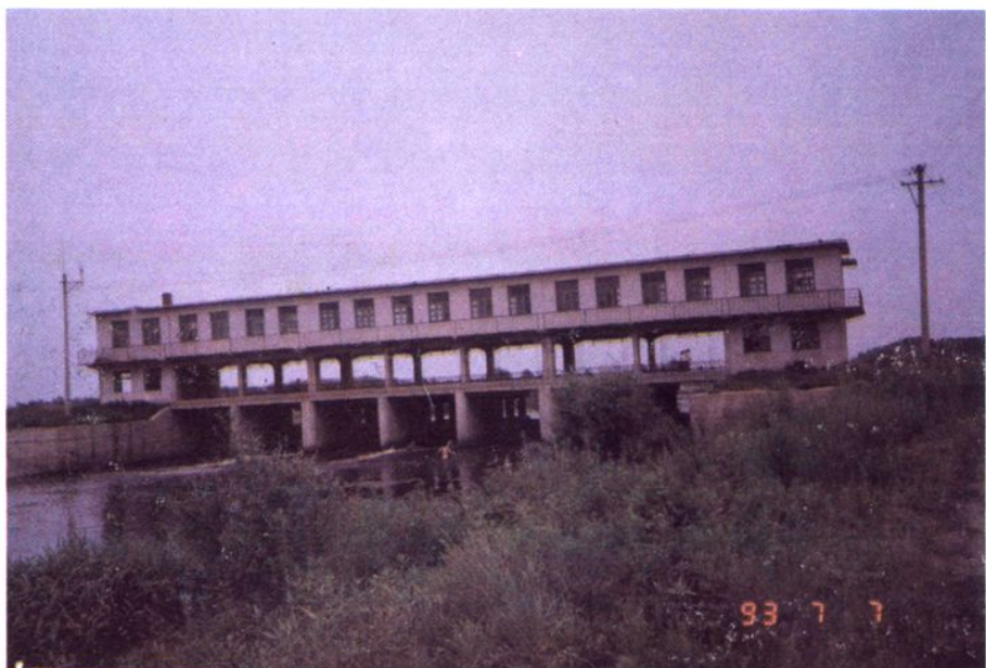
沈抚污水灌区下伯官七孔闸
