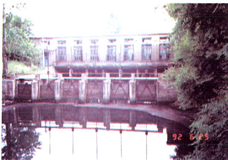
沈抚污水灌区下伯官提水站
