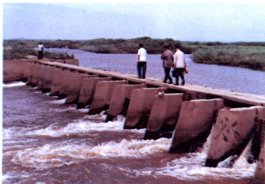
沈抚污水灌区十九孔闸
