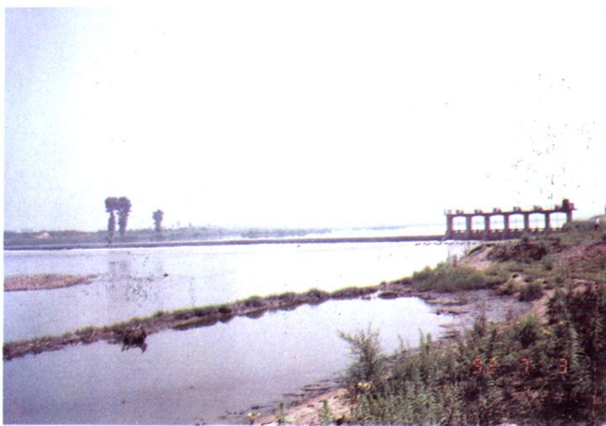
沈抚污水灌区丰乐拦河坝
