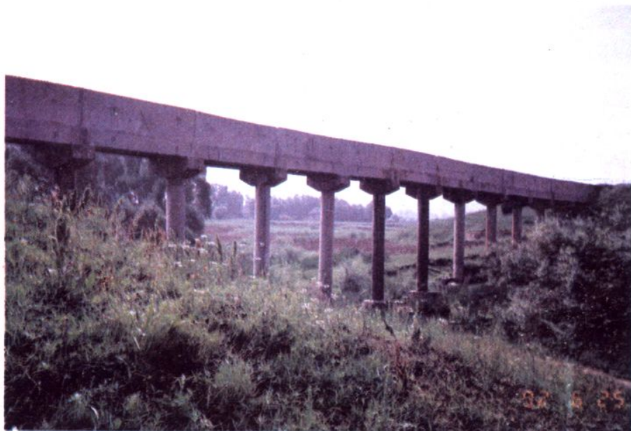
班家寨提水站二板桥渡槽
