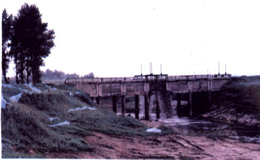
沈抚污水灌区施家寨渡槽
