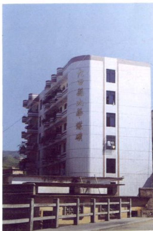
太华煤矿大楼
