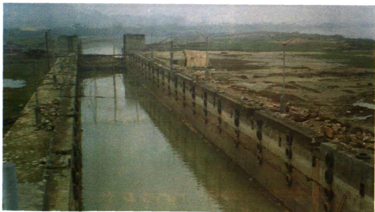
列入国家“七五”计划时期重点工程之一的九龙江西溪复航工程正在施工中
