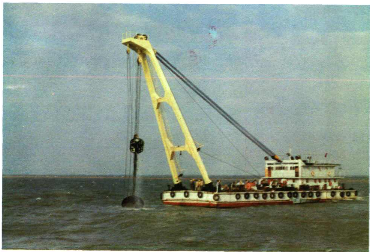
福建省第一艘沿海80吨起重机船在闽江口抛设弹性灯桩
