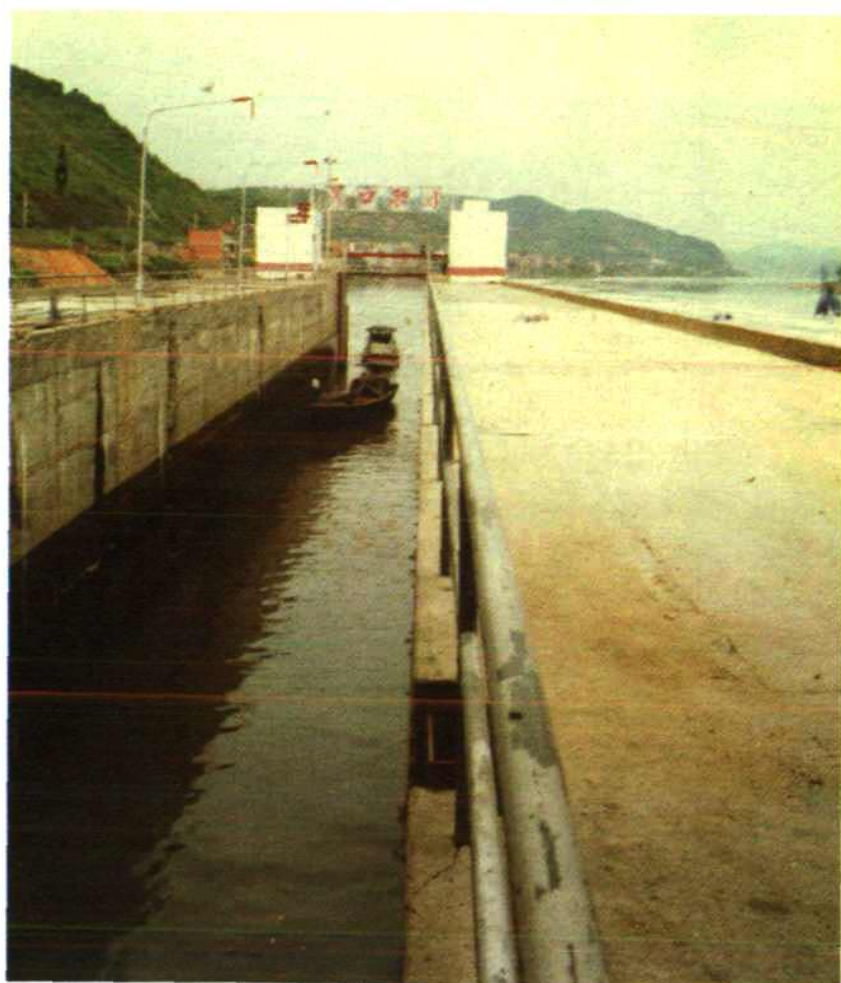
闽江复航第一闸—— 富屯溪洋口船闸
