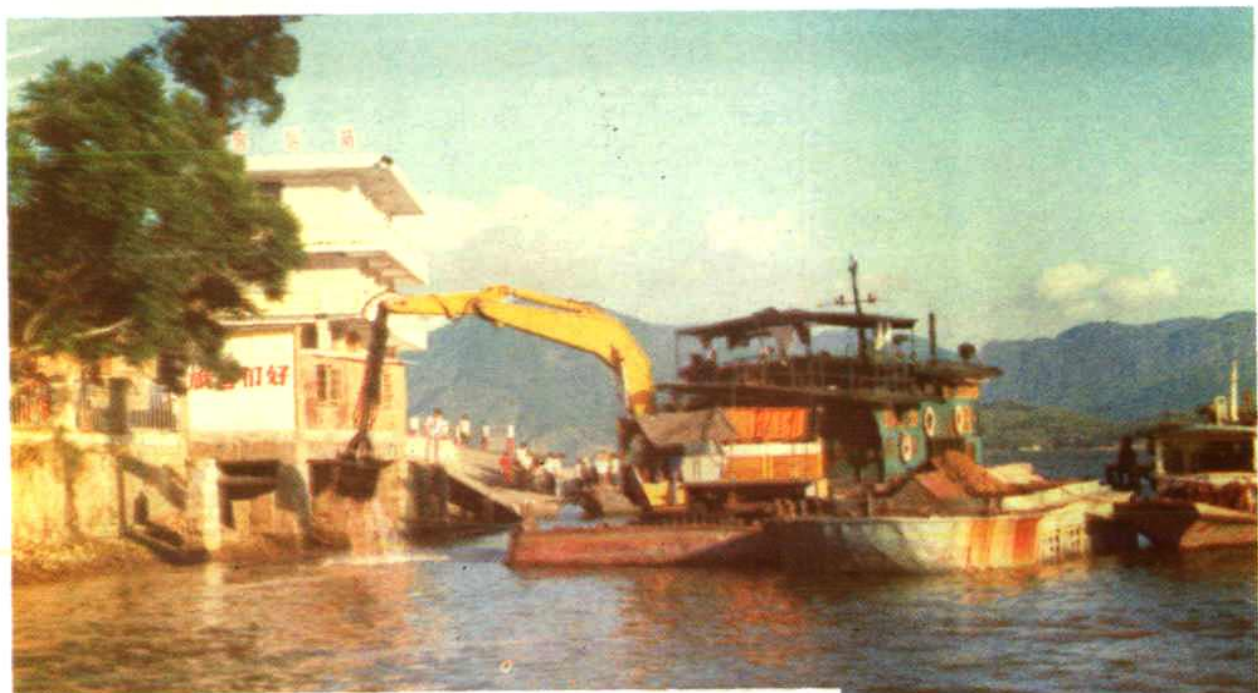
“闽抓108号”抓斗式 挖泥船在闽江干流南港 湾边码头前沿疏浚
