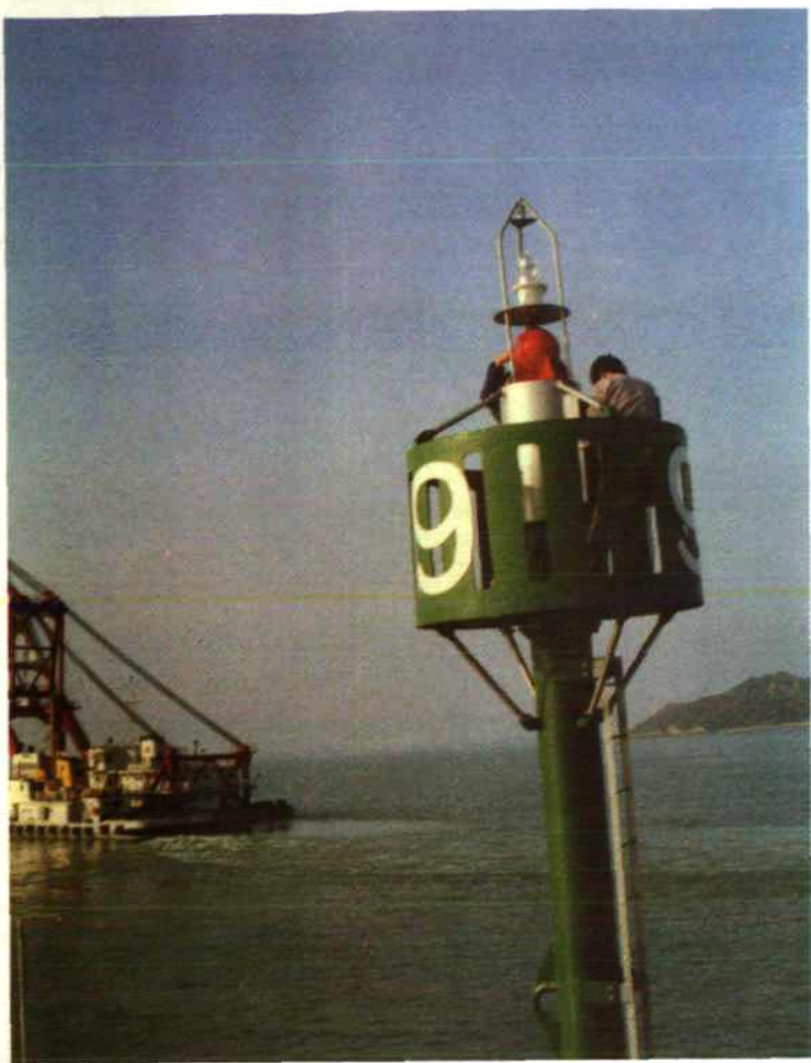
湄洲湾航道设置的国内大型弹性灯桩之一
