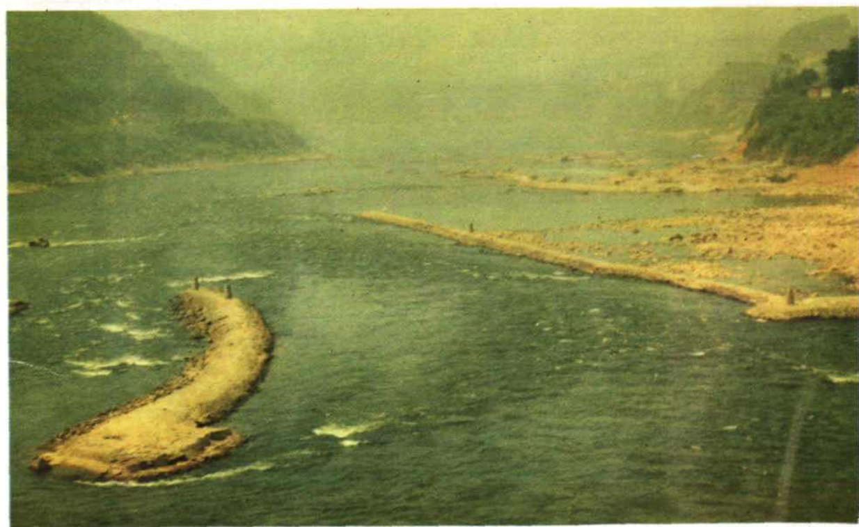
闽江支流建溪黯淡滩整治工程建筑物
