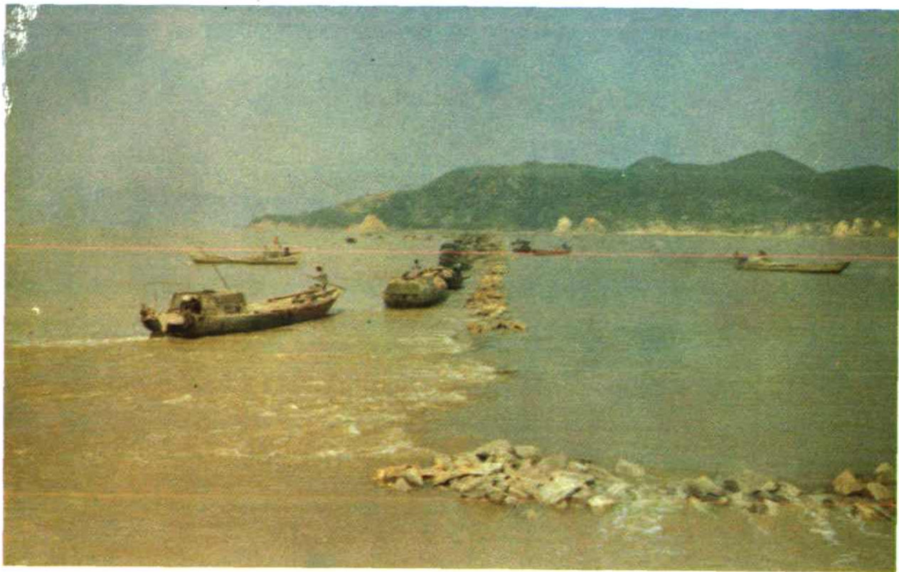
闽江口航道整治抛坝施工现场
