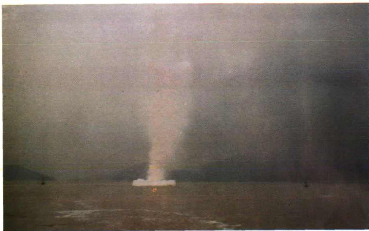
闽江通海航道马祖印水下炸礁工程
