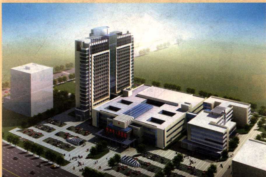
正在新建的忻州市人民医院综合楼鸟瞰图
