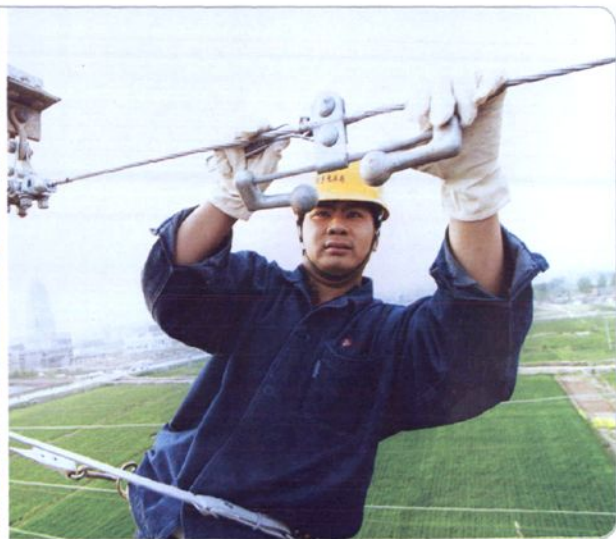
输电线路工程高空作业现场
