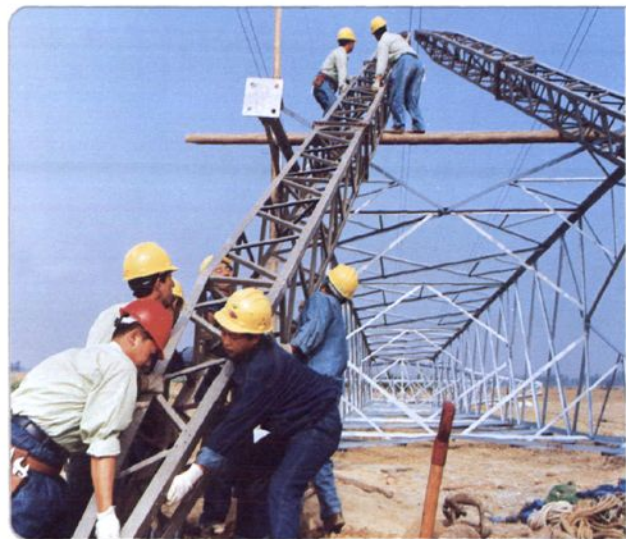
220千伏新洪输电线路升高工程施工现场
