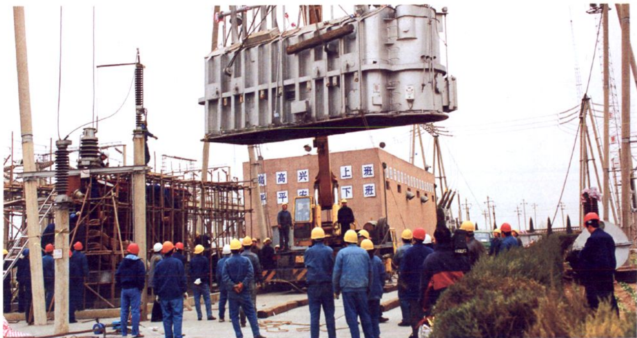
2001年2月220千伏古固寨变电站主变压器大修
