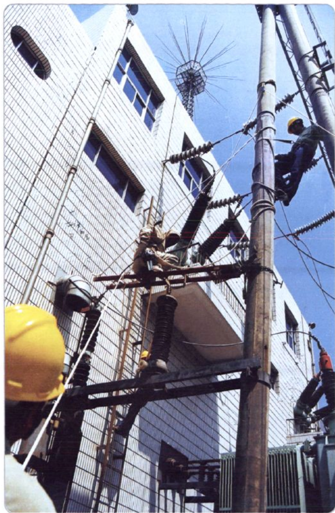
带电作业施工现场
