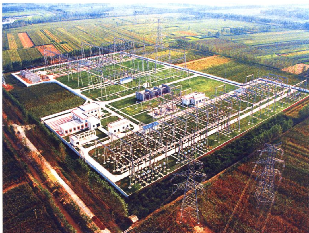
500千伏获嘉变电站
