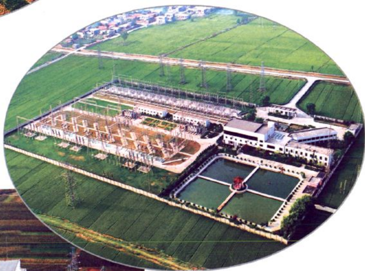
220 千伏洪门变电站
