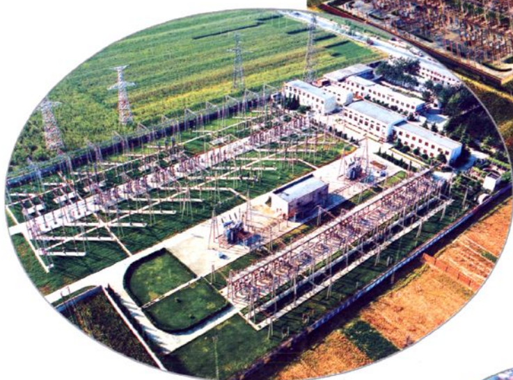
220 千伏古固寨变电站
