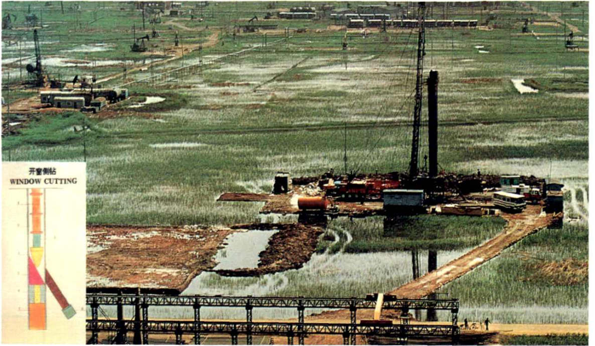
大修侧钻施工现场
