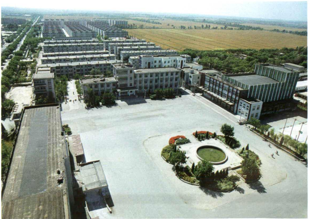
井下作业公司驻地南区面貌
