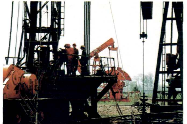
大修侧钻施工现场
