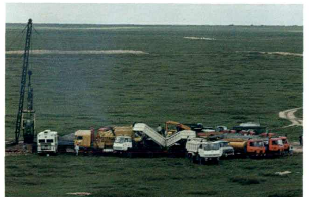
开鲁大草原压裂施工
