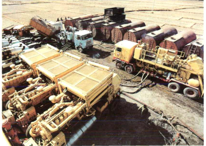
大型压裂施工现场
