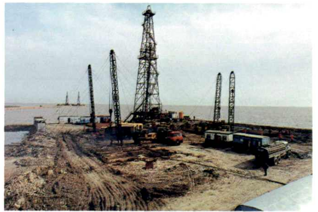
修井作业现场
