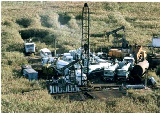
芦荡压裂施工
