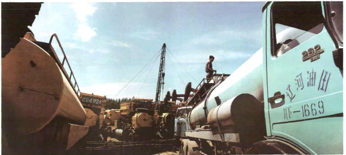
在内蒙古大草原大型施工
