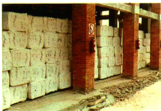
轧花厂储棉长廊
