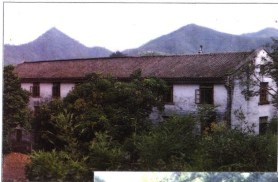
老校址办公楼
