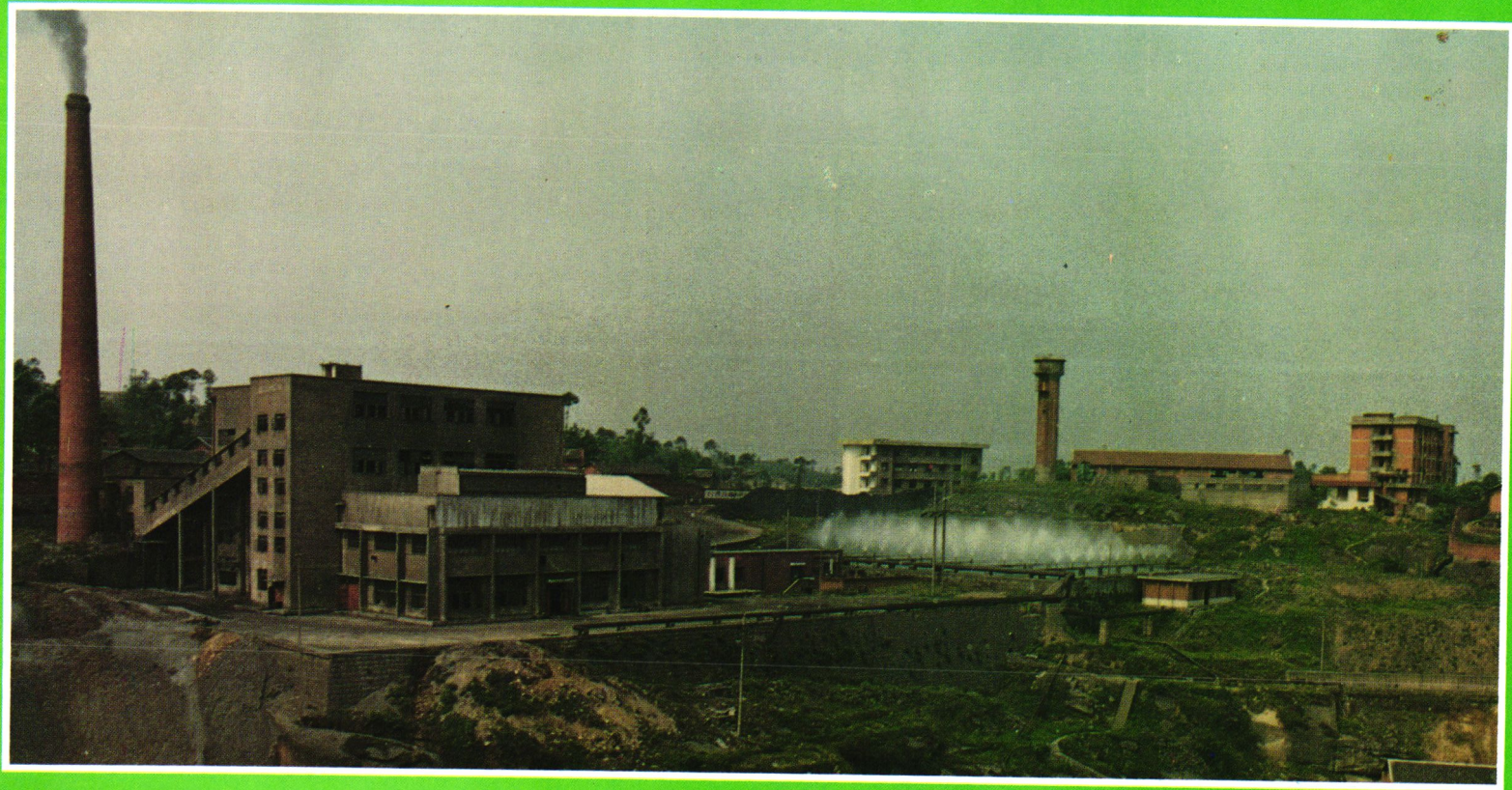
▲威远县发电厂全景(威远县乡镇企业局直属厂之一)
