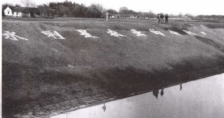
施工工地一角
