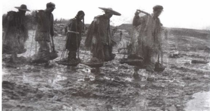
1958年浏河工地春节后阴雨连绵,英勇的劳动人民提出“晴天加劲干、小雨坚持干”的口号。图为泥泞路滑,河深坡陡继续干的场面。
