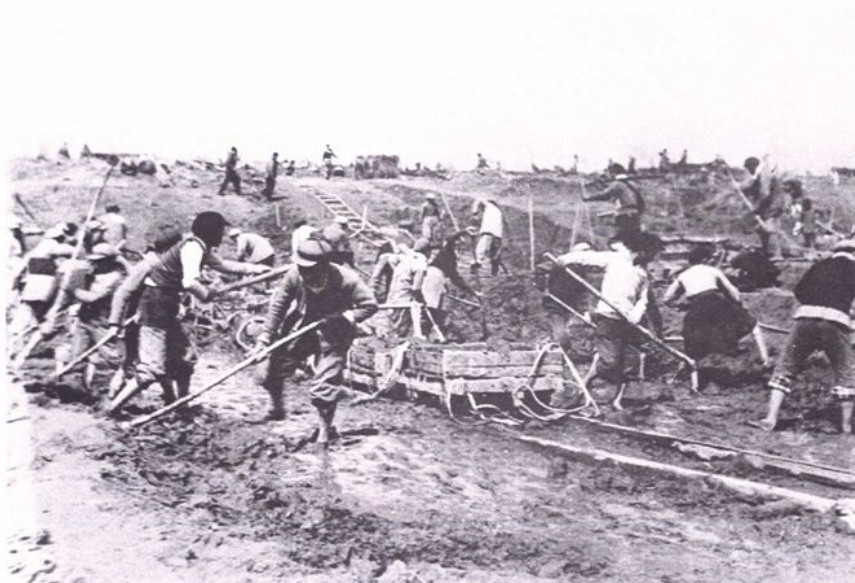
1958年开拓浏河工地一角
