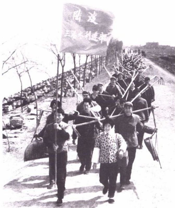
陆渡公社开河民工出工上工地场景
