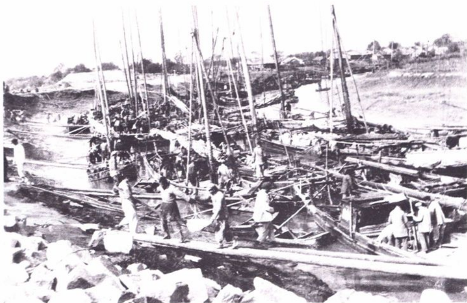
因建闸工程需要,大批的器材物资昼夜不停地运往水闸工地。
