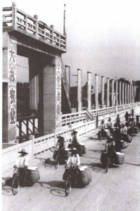
通过浏河水闸桥运送棉花入库
