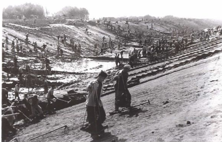
施工工地场景
