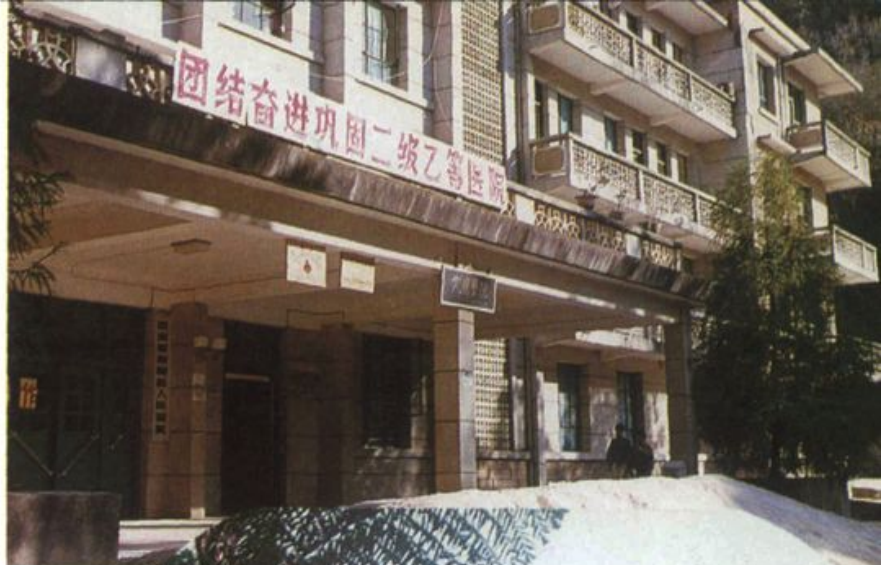
► 县人民医院住院楼
