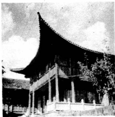
腾冲县供销社职工教学楼、招待所
