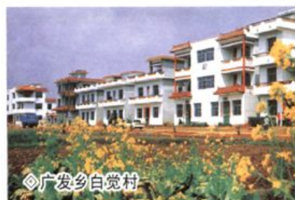
◇ 石桥镇政府办公楼
