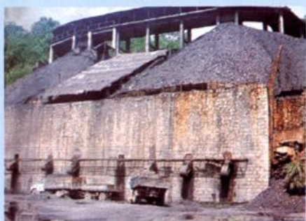
◇罗卜安煤矿万吨煤仓
